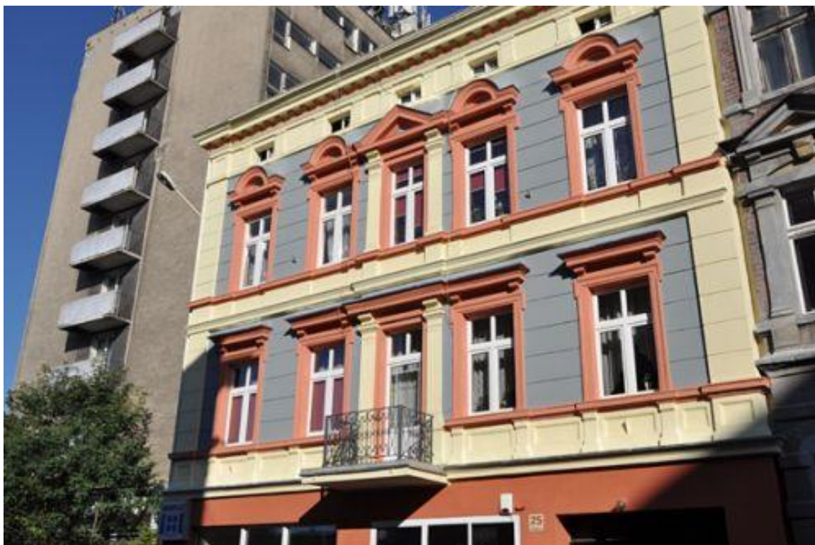
Zdjęcie 4 Kamienica przy ul. Mickiewicza 25 po rewitalizacji. Źródło UM Kluczbork.
