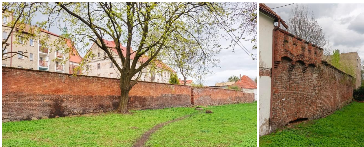
Mury miejskie i pozostałości fosy od strony południowej miasta, fot. własne
