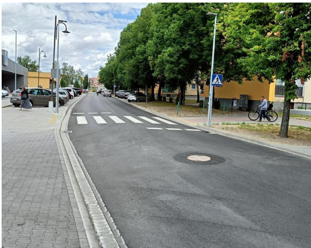
Remont ul. Grunwaldzkiej
